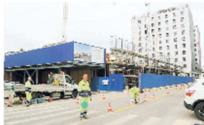
La nuova viabilità per il cantiere del raddoppio dell'ostello AO (Carafussi)
